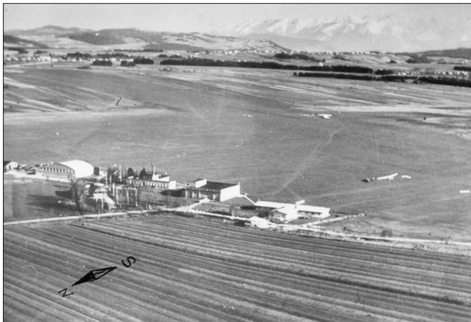
Fot. 13. Widok lotniska w Nowym Targu z samolotu, lata 1961–62, w trakcie rozbudowy, nowo wybudowany pas startowy w kierunku E
