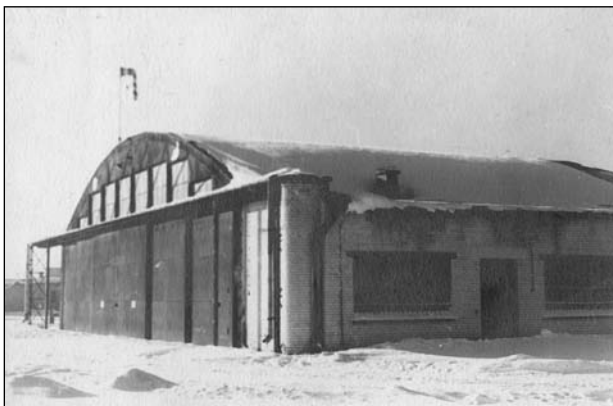
Fot. 11. Hangar w latach 60. w Nowym Targu
