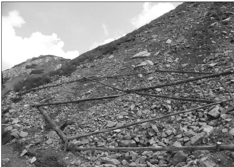
Fot. 7. Drewniany szalunek o wypełnieniu kamiennym – podejście na Świstową Czubę
