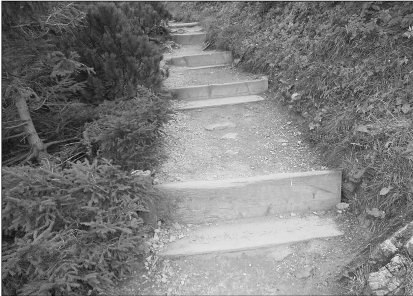
Fot. 6. Stopnie ziemne wzmocnione belkami – Dolina Jaworzynki
