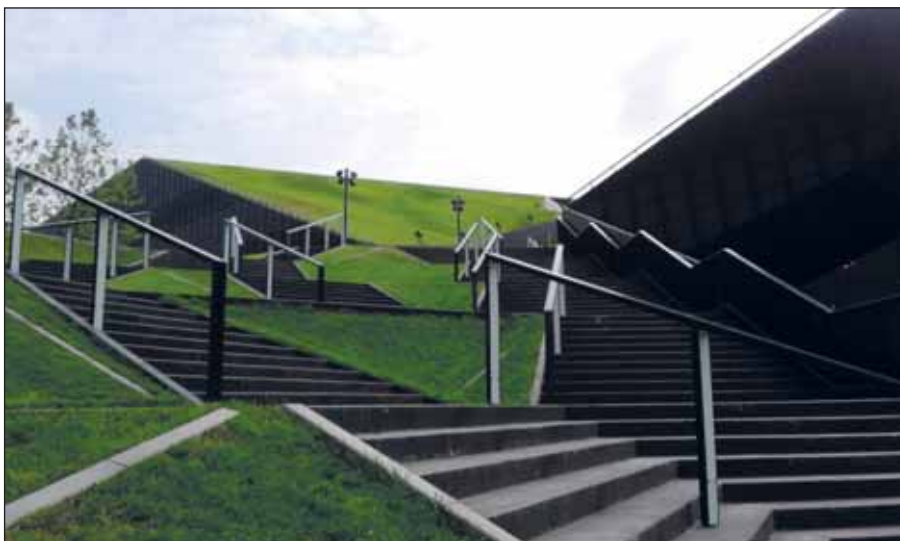
Ryc. 3. Zielona infrastruktura Międzynarodowego Centrum Kongresowego w Katowicach, fot. Dagmara Chylińska (2016)
